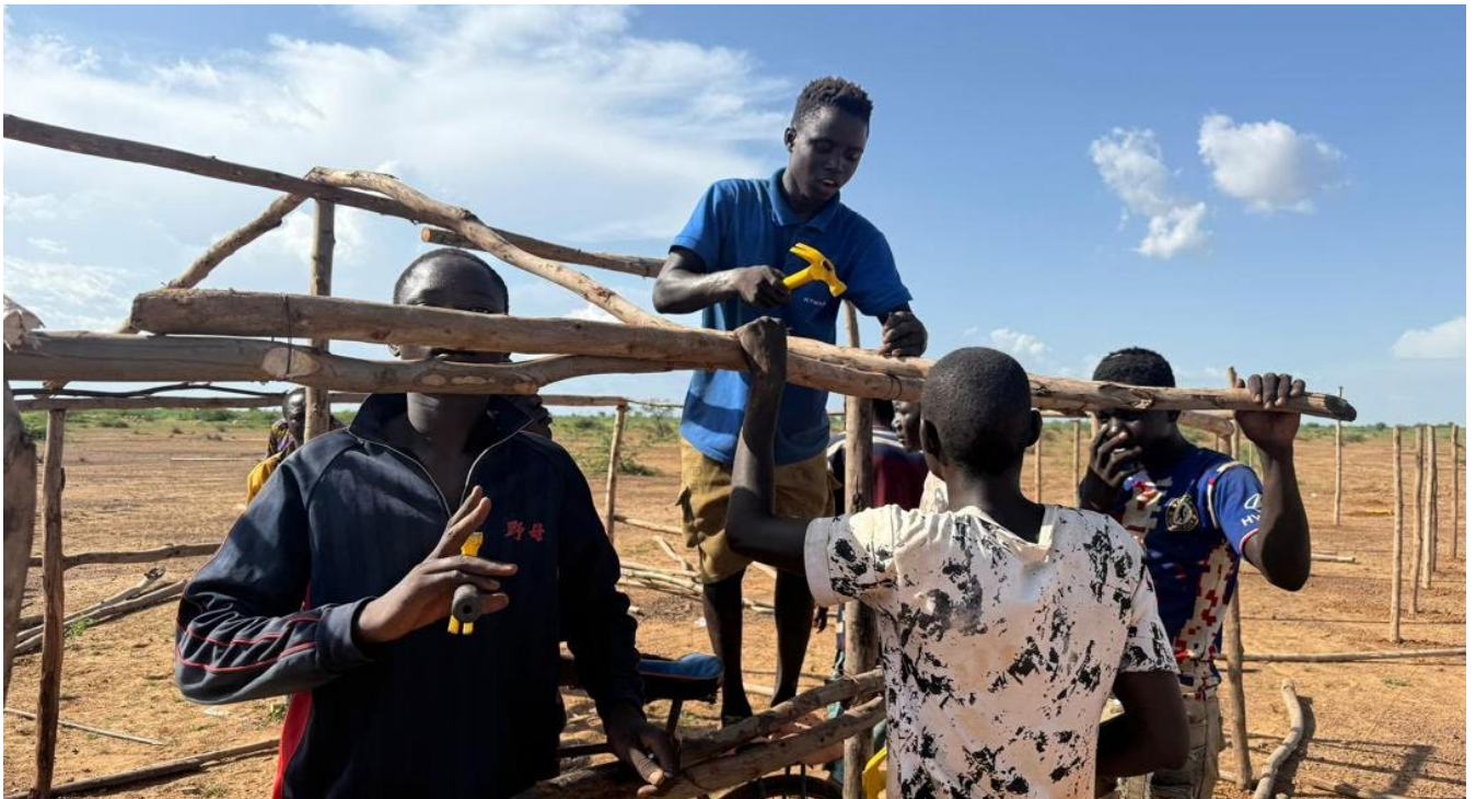
Image Construction d'abris transitoire à Koro, le 19 septembre 2025
